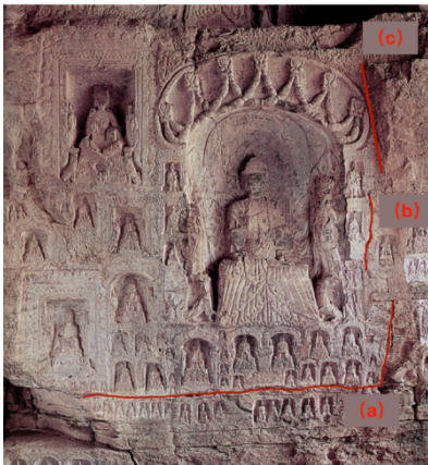
図 7 南壁の亀裂と整備痕跡 出典:『優師水泉石窟』筆者加筆
