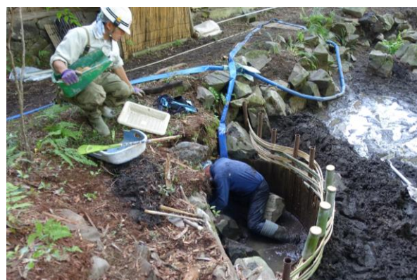
写真4 水処理管理技術(漏水部分修復)
