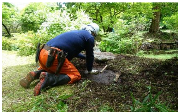
写真3 堆積土除去の様子
