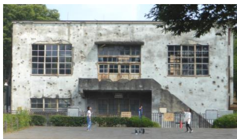
図2 旧日立航空機株式会社変電所
