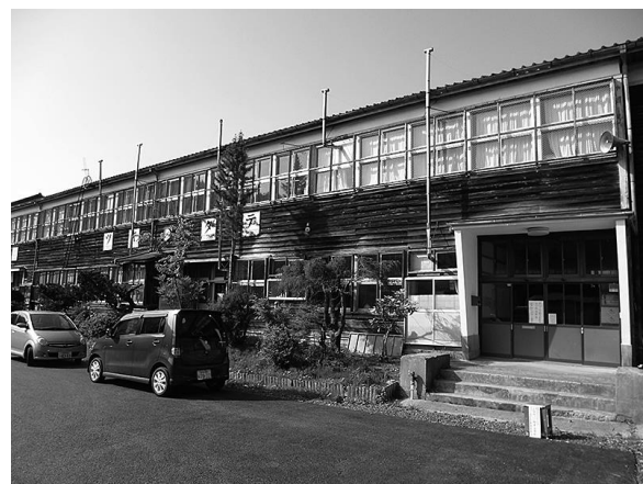
写真2. 気仙沼市旧月立中学校(被災資料収蔵庫として利用) 注2
