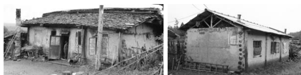
写真3 錦江村の井幹式民家（左）と新築井幹式民家（右）
