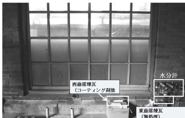
図12 繰糸工場南側通路の写真
