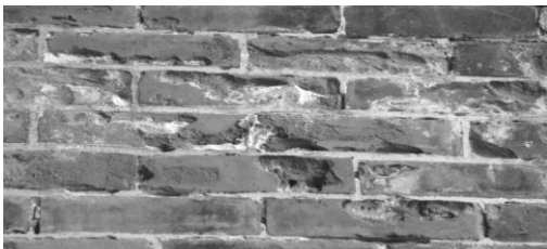
図 1 群馬県碓氷峠鉄道 碓氷トンネルの壁面における塩類風化
